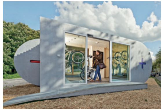
Mobile, modulare Ladestation in Holzbauweise für elektrisch betriebene Fahrzeuge
