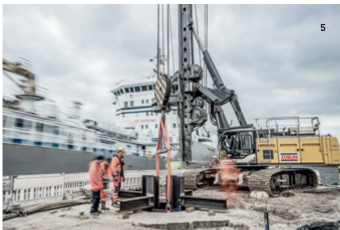
1 Trogbaugruben Autobahnring A100, Berlin/ 2 Detail Neubau Hauptsammler West, Bau des Tiefbahnhofs, Stuttgart 21/ 3 Bohrpfahlschacht Versorgungsdüker Schleuse Kiel-Holtenau, © Sebastian Engels Fotografie, www.sebastian-engels.de/ 4 Vereisung Schutzdach, U-Bahn Haltestelle Severinstrasse, Köln/ 5 Stahlrohrschächte, Versorgungsdüker Schleuse Kiel-Holtenau, © Sebastian Engels Fotografie, www.sebastian-engels.de/ 6 Erweiterung MCT-Kai Port Louis, Mauritius
