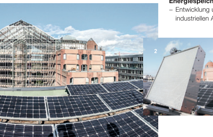
1 Lichtkollektor, Tageslichtlenkung Z3, Stuttgart / 2 Photovoltaik Z3, Stuttgart
