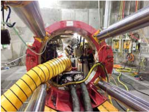
◀ Eingangsschacht der Gasleitung im russischen Anapa / Entry pit of the gas pipeline in Anapa/Russia
