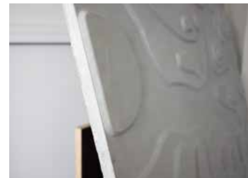
► UHPC-Fassadenelement mit einer Dicke von 2,3 cm / UHPC facade element with a thickness of 2.3 cm
