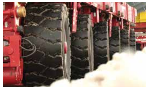
▶ Self-propelled platform (SMPT) with axle loading of 14.2 Mg is testing the binder&anti-fatigue layer before opening the area for internal traffic / Selbstfahrende Plattform mit Achslast von 14,2 Mg testet Binde- und Anti-Ermüdungsschicht
