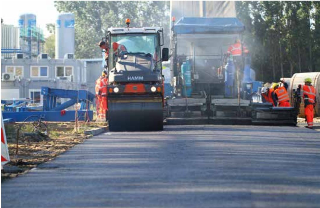
► Paving and compaction of SMA 22 PMB 25-55/80 binder course on SMA 16 PMB 45/80-80 (anti – fatigue base course) / Einbau der SMA 22 PMB 25-55/80 Binderschicht auf die SMA 16 PMB 45/80-80 Anti-Ermüdungsschicht
