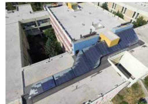
► Demonstrationsanlage für die Dachintegration in Athen / Roof demonstration plant at NTUA in Athens
