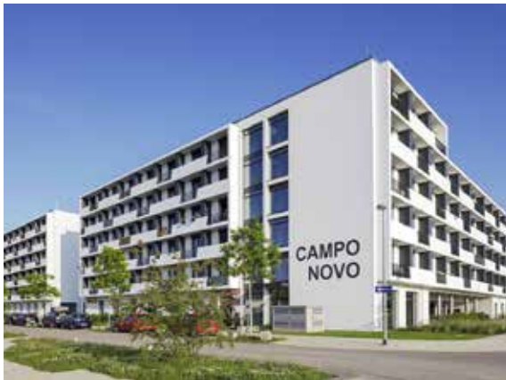
Studentenwohnheim Campo Novo, Freiburg
