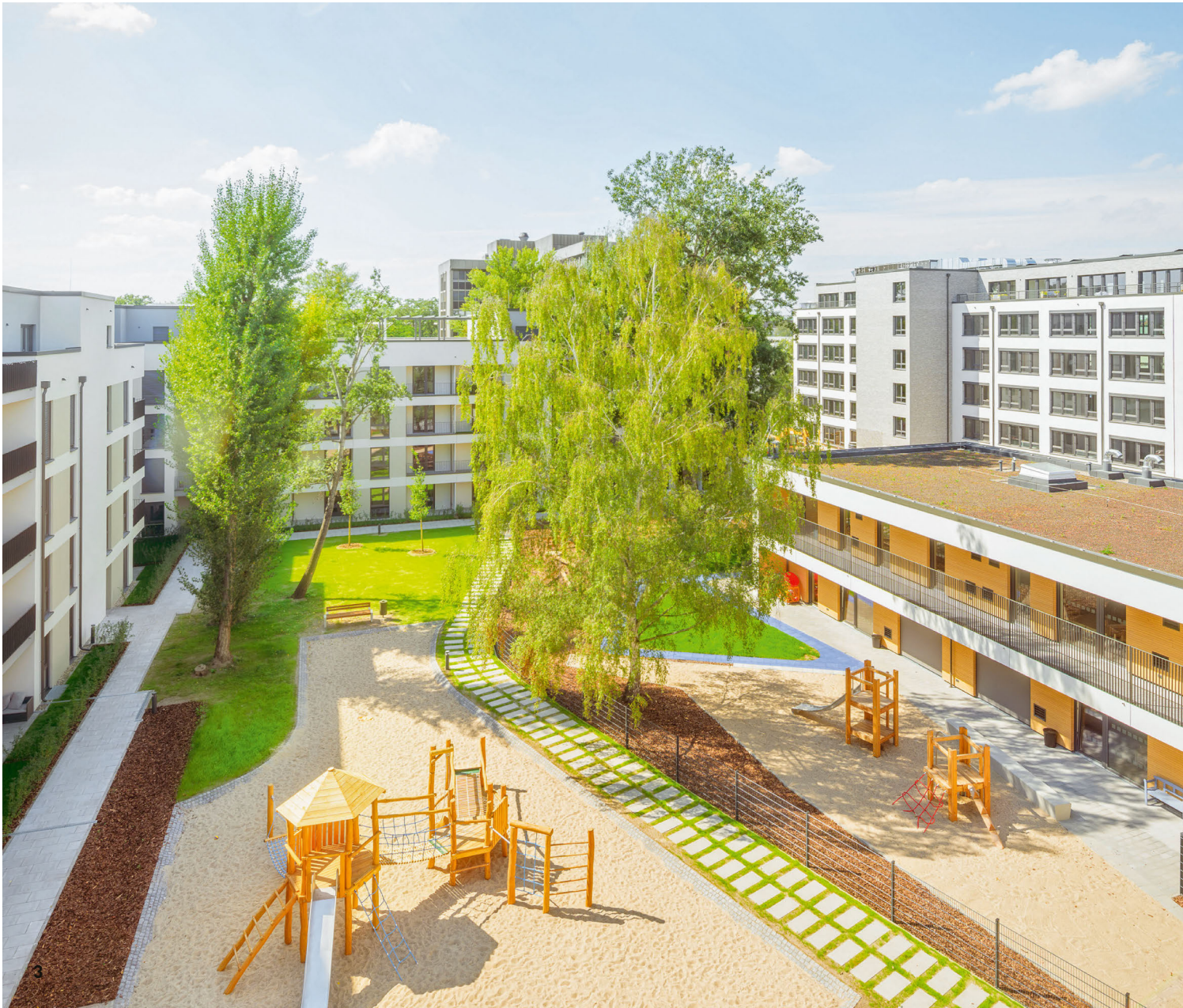
3-4 My Tegel mit Kita sowie Wohn- und Bürogebäuden © Franz Brück
